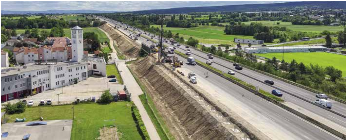
Die Arbeiten am neuen Lärmschutz an der A2 schreiten voran.
