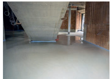
.... und der Estrich wurde bereits verlegt.
