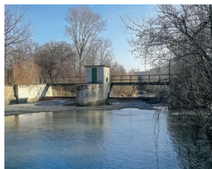
Das Teilungswerk in Enzesfeld wird mit moderner Technik komplett erneuert, um die Wasserläufe bei Hochwasser genau steuern zu können.
