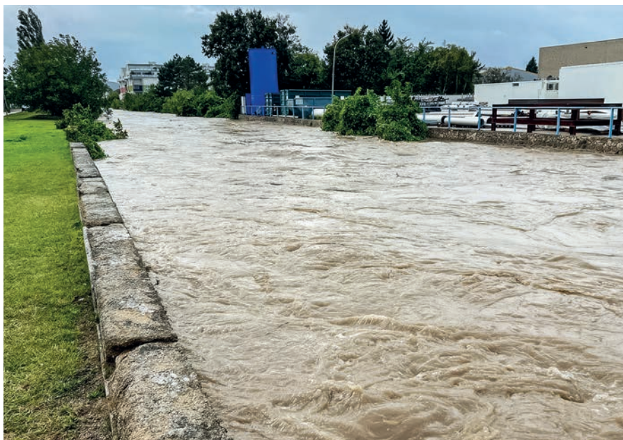
Der Hochwassergraben im Bereich der Firma GWT drohte schon mehrmals über die Ufer zu treten.
