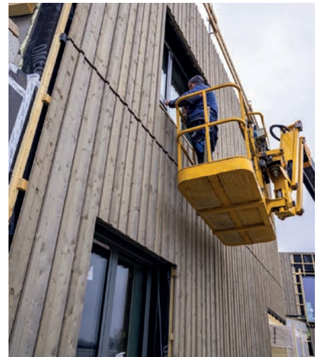
An der Außenfassade wird fleißig gearbeitet....
