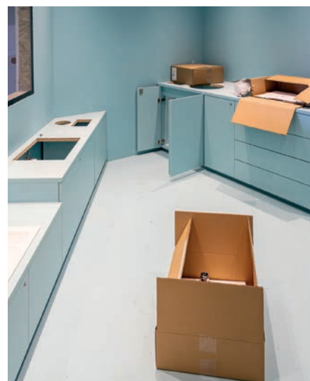
Momentan wird fleißig an der Außenanlage gearbeitet und die Möbel aufgebaut.
