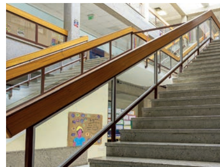
Die Erneuerung der Stiegegeländer in der Aula soll für zusätzliche Sicherheit sorgen..
