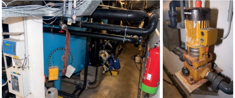
Die Technik im Schwimmbad wird in den nächsten Monaten schrittweise erneuert.
